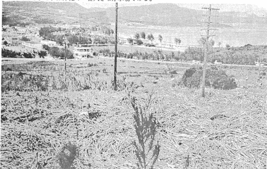
石川浄水場建設用地
