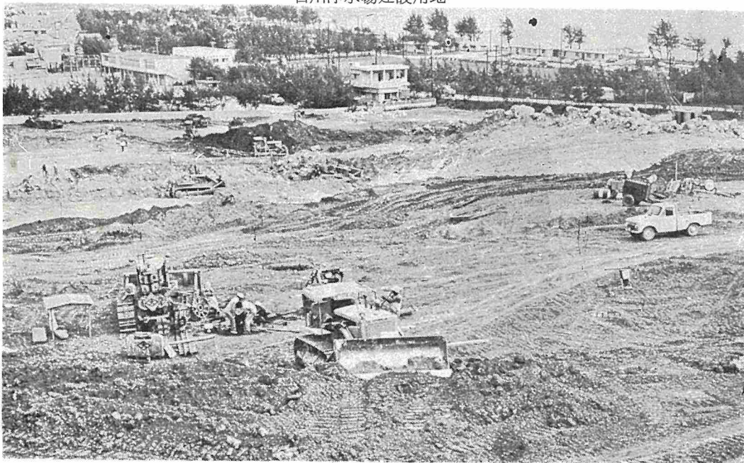
石川浄水場建設用地の地ならし
