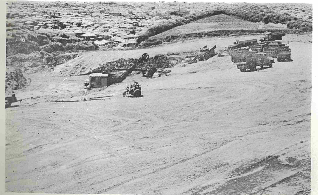
那覇港をバックにした那覇貯水タンクの建設現場
