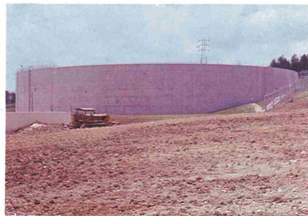
一千万ガロン原水タンク
