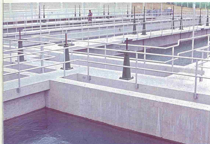
凝集攪拌池、沈澱池および濾過池
