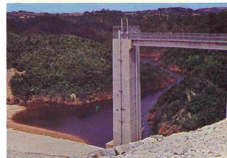
天願ダムの水門塔
