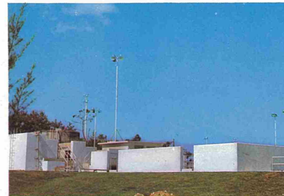
タイベース浄水場の凝集攪拌池
