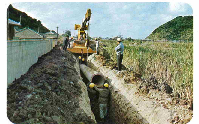
羽地村源河に於けるパイプ敷設工事
