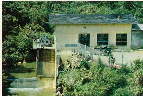
比謝川ポンプ場
