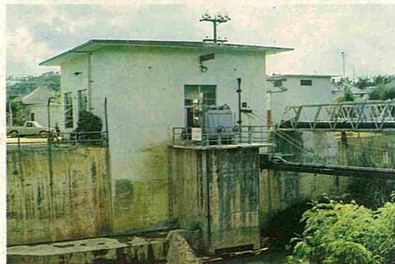
川崎ポンプ場
