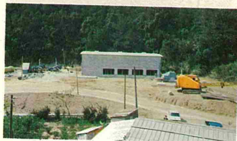
← 福地ポンプ場
