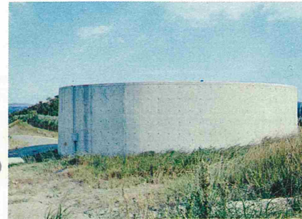
豊見城配水タンク (50万ガロン)
