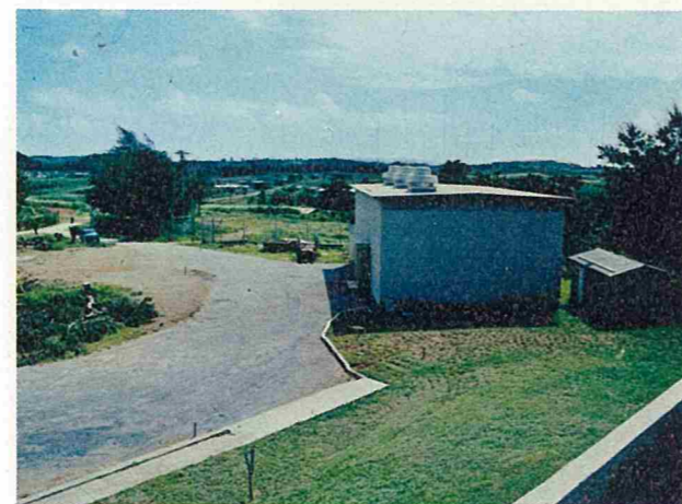
天願送水ポンプ場 (1,300万ガロン/日)
