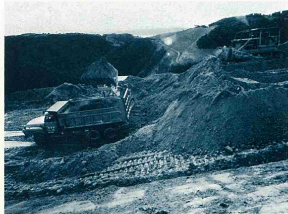
福地ダムの建設現場
