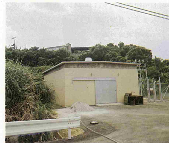
渡口増圧ポンプ場
