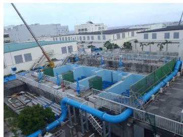
北谷浄水場の更新
