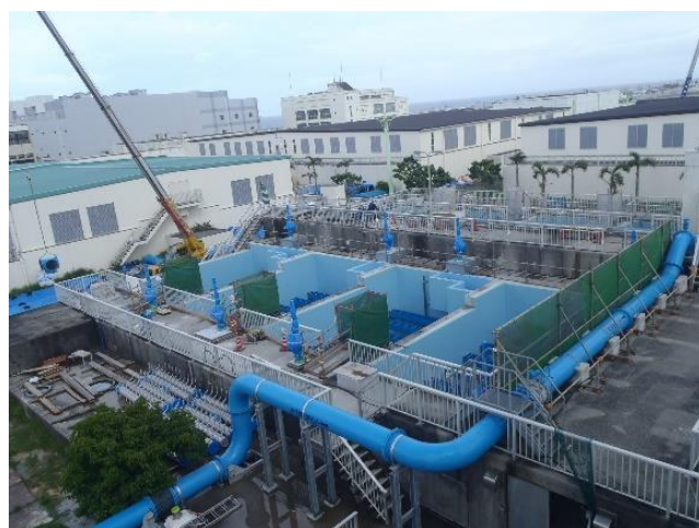
北谷浄水場の更新
