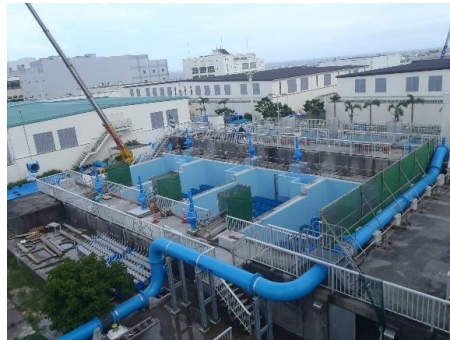
北谷浄水場の更新
