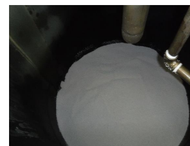
離島海水淡水化施設のミネラル添加材として利活用
