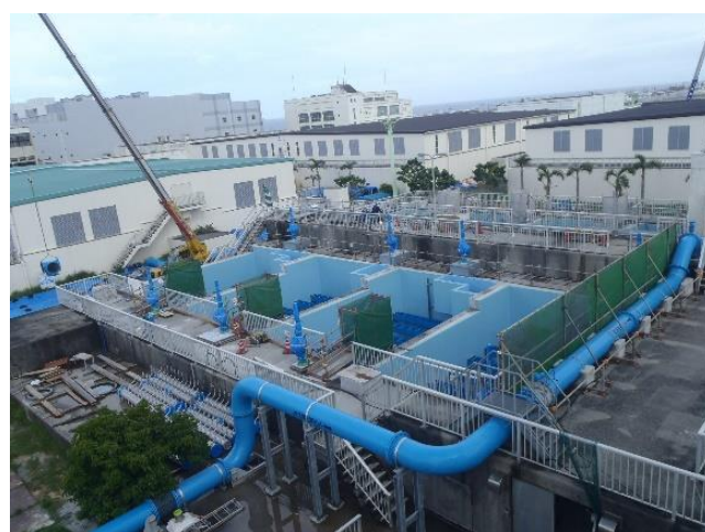
北谷浄水場の更新
