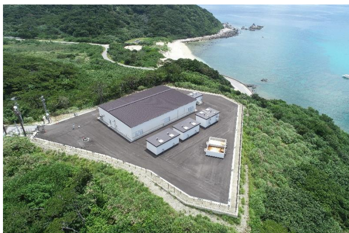
座間味村（阿嘉島）の海水淡水化施設
