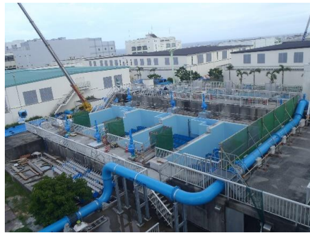
北谷浄水場の更新
