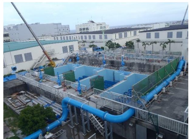
北谷浄水場の更新
