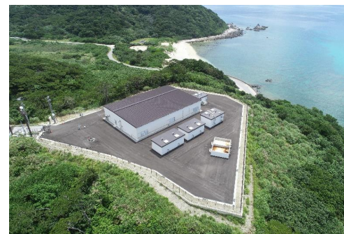
座間味村（阿嘉島）の海水淡水化施設
