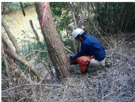
山城ダム被害木伐採
