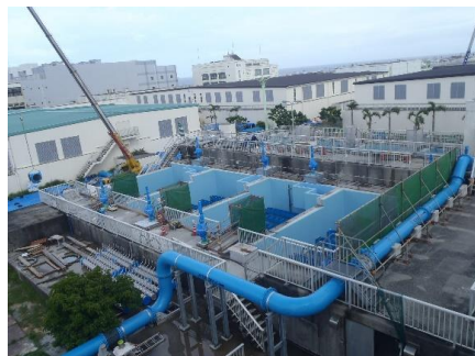
北谷浄水場の更新
