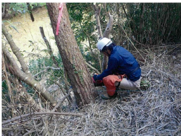
山城ダム被害木伐採
