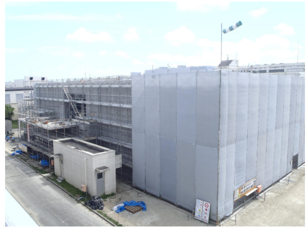
北谷浄水場薬品注入棟建築工事
