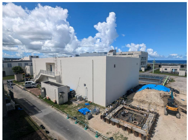
北谷浄水場薬品注入棟建築工事
