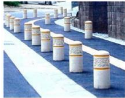
生成ペレットを活用した車止め
