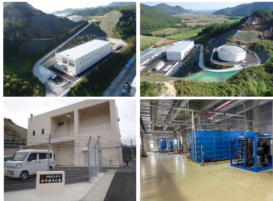
伊平屋浄水場(伊平屋村)
