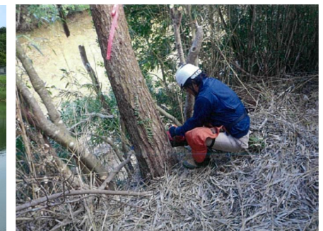
山城ダム松食い虫被害木伐採
