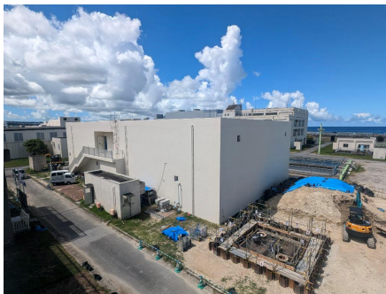
北谷浄水場薬品注入棟建築工事
