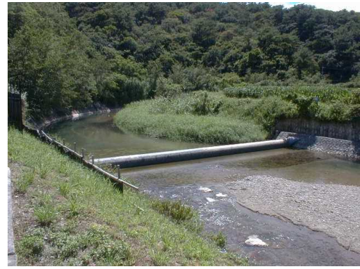
源河川取水施設
