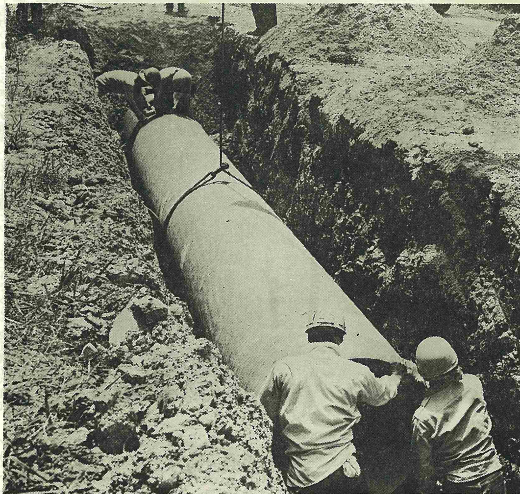
東部送水管の36インチコンクリートパイプ敷設工事
