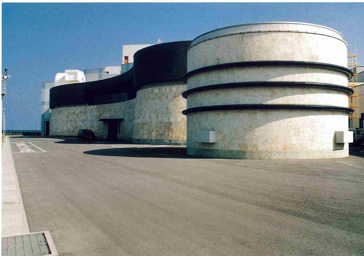
MOF 棟と電気棟
