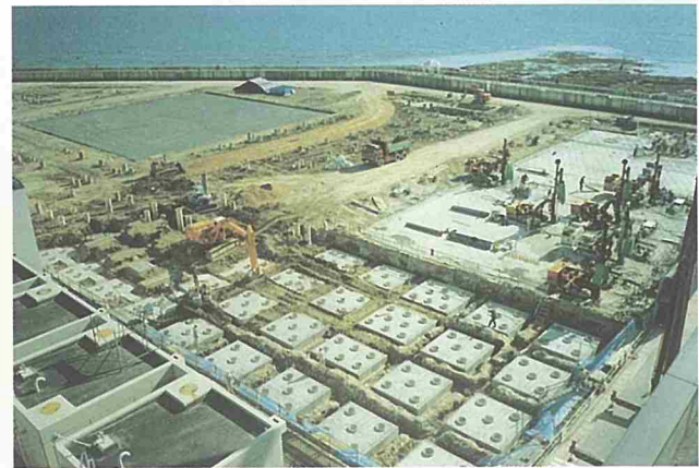
床版コンクリート打設
