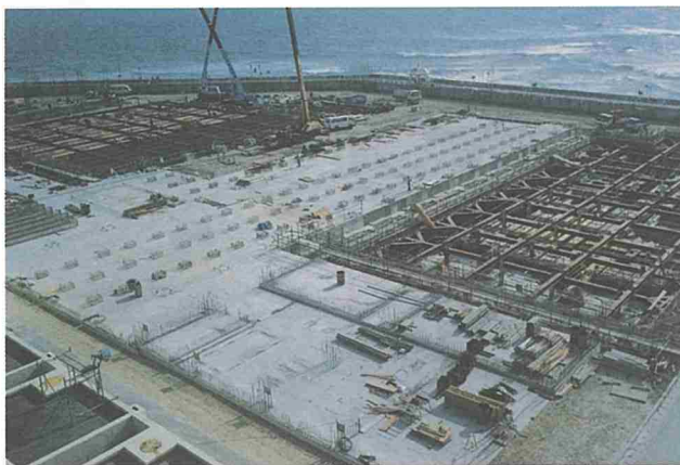
1階部分床版コンクリート打設
