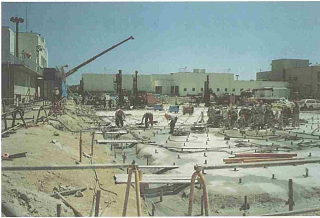
薬注工：ソレタンシュ工法（１）
