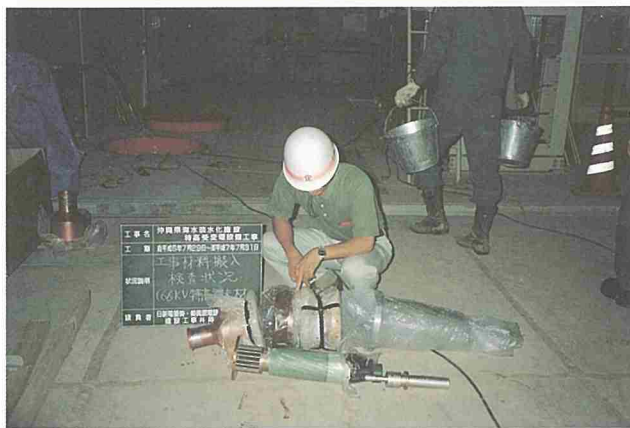
66kV 特高ケーブル用端末処理材搬入検査
