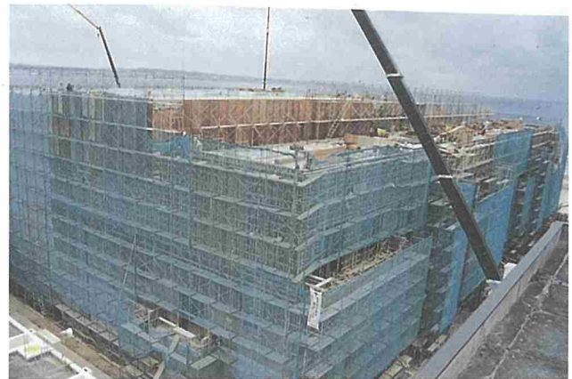
型枠・足場の設置
