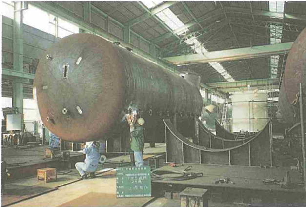
ろ過機鏡板の溶接組み立て
