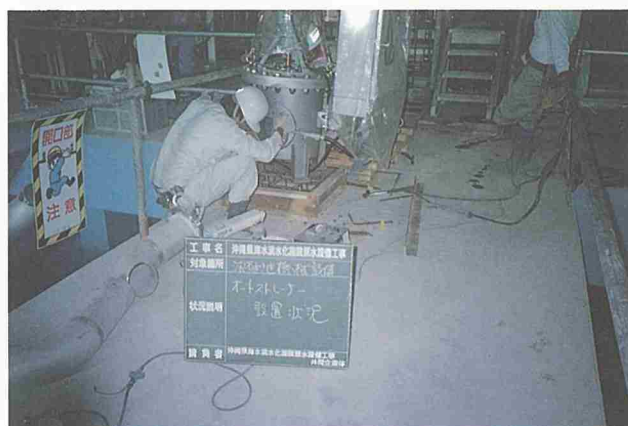
除塵機洗浄用オートストレーナーの据付
