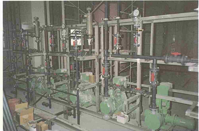
ポンプ廻り配管・弁類の接続
