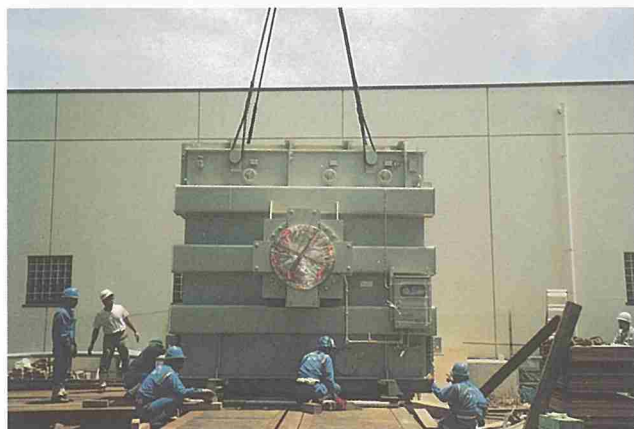
66kV 級 GIS の搬入・据付
