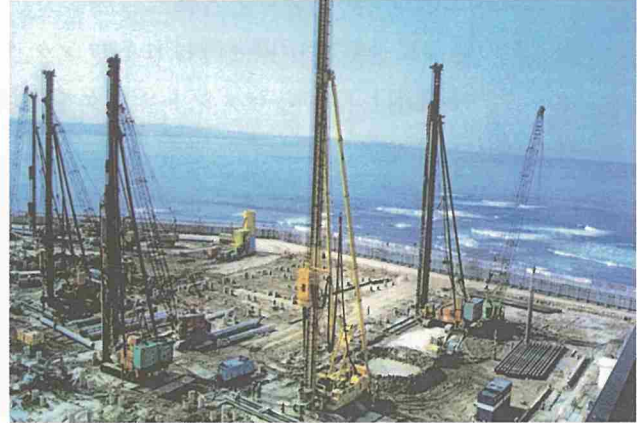
地盤改良工：JSG工法（２）
