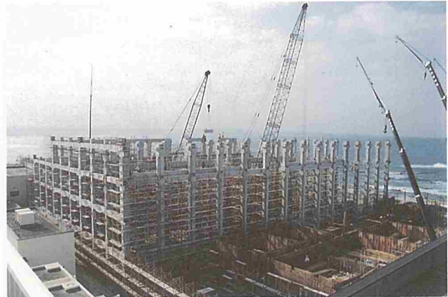
P C梁の設置
