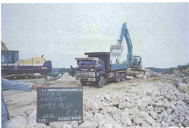
土砂の掘削・積込み
