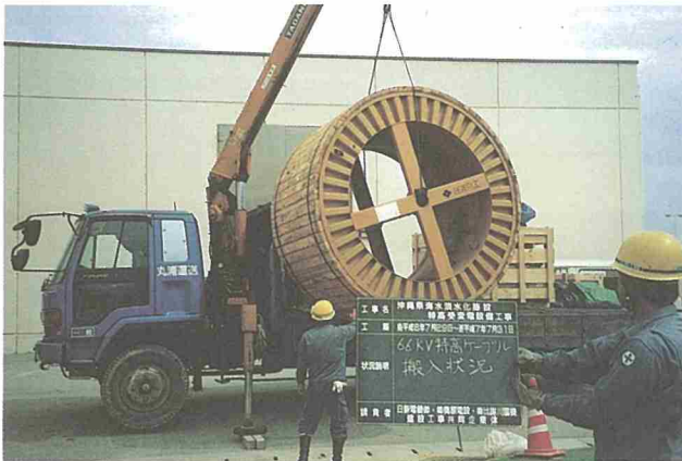
66kV 特高ケーブルの搬入状況
