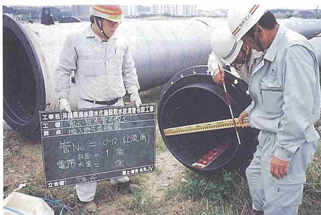
配管資材の検査 (1)
