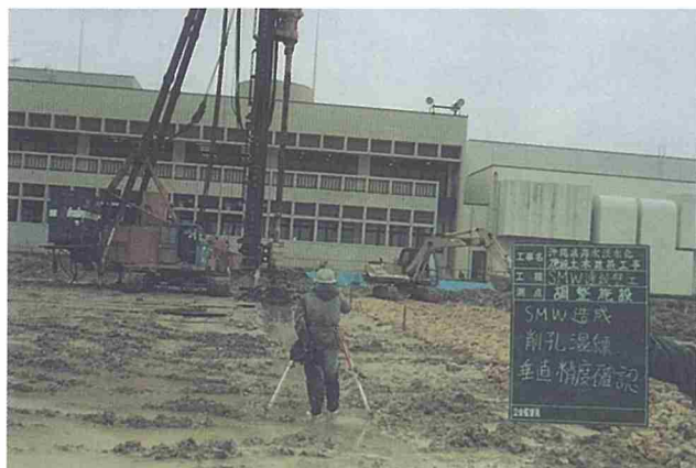
SMW工法造成（1）
