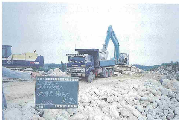
被覆石の積み込み（陸上）
