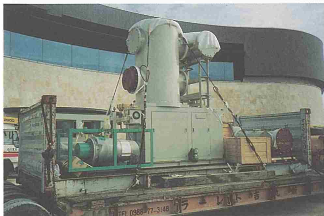
66kV 級 GIS の低床トレーラでの搬入
