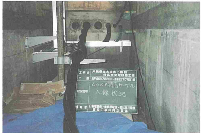
66kV 特高ケーブルの据付状況
