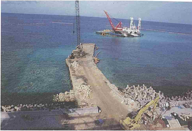
養生堤の築造 (1)
