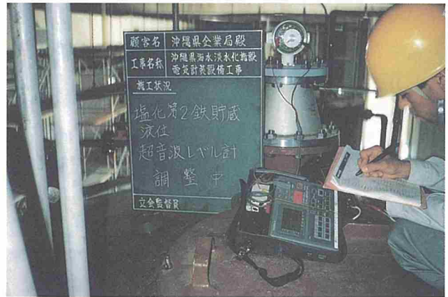
超音波水位計の試験調整
