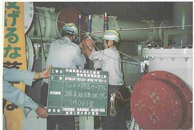
66kV 特高ケーブル用端末処理接続状況
