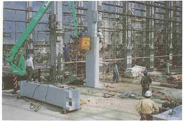
P C柱の固定
