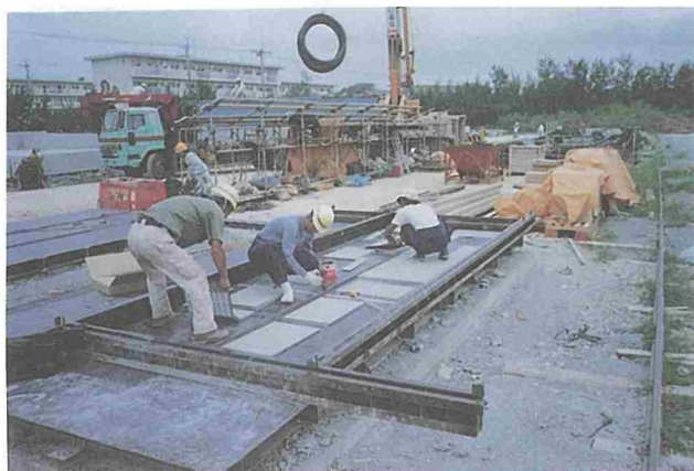
PC柱の型枠工
