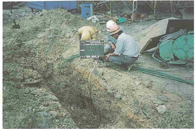
接地極板埋設後の抵抗測定試験
