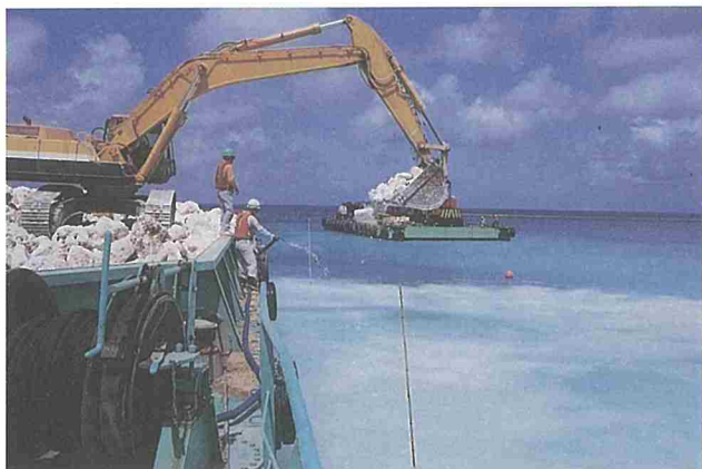
置砂及び被覆石の投入
