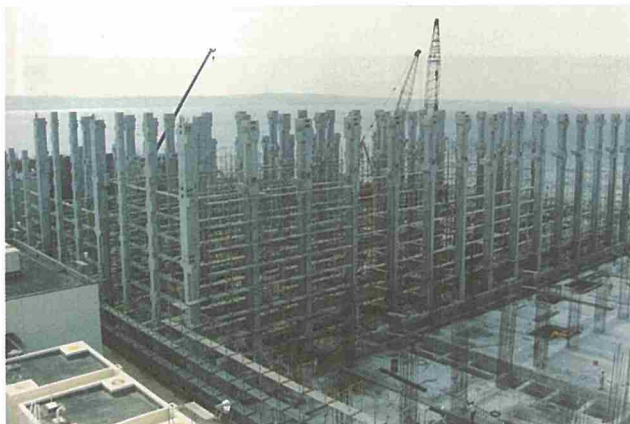
P C柱の設置
