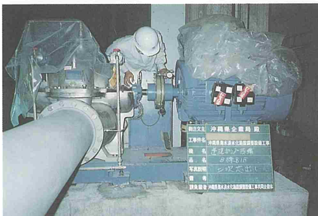
洗浄ポンプの据付
