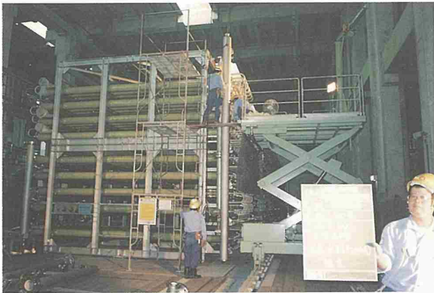
ROユニット据付
