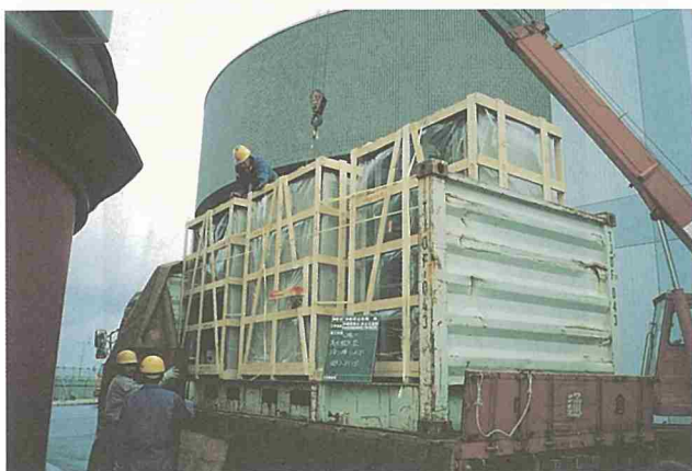
C V C F 装置の現場搬入状況
