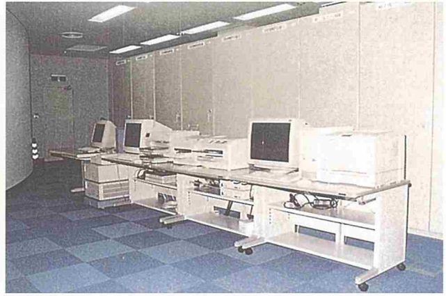
計算機室機器据付状況
