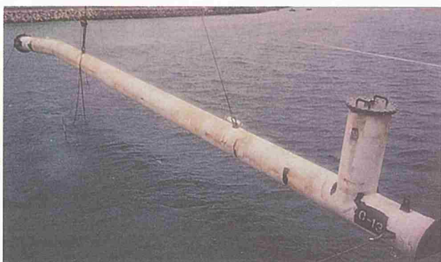
取水放流管の吊下し（深海部）
