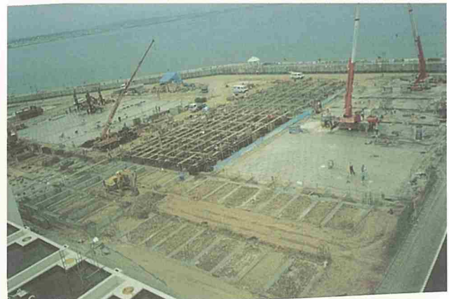
基礎及び止水工仕上（２）
