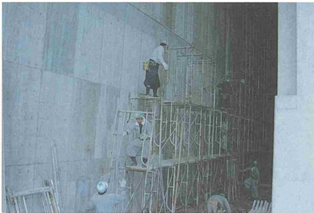
内外壁の設置
