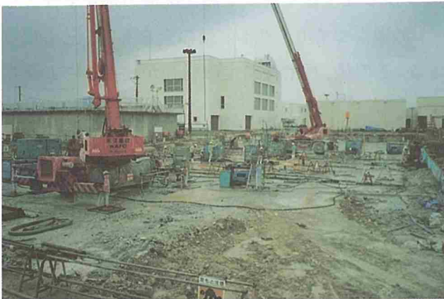
地盤改良工：JSG工法（１）
