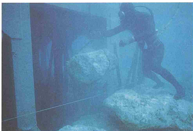
取水口周辺の被覆石投入
