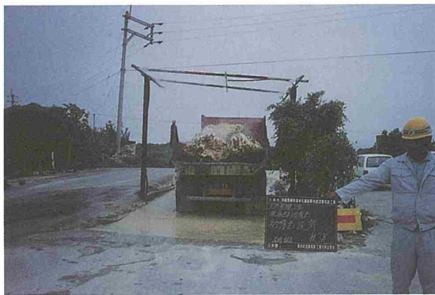
土捨場（防塵処理）
