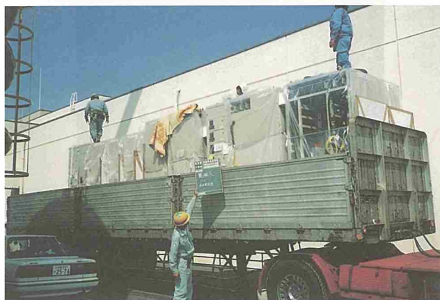
閉鎖配電盤の搬入
