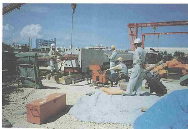
隣接するPC柱製作工場にて、PC柱を製作
