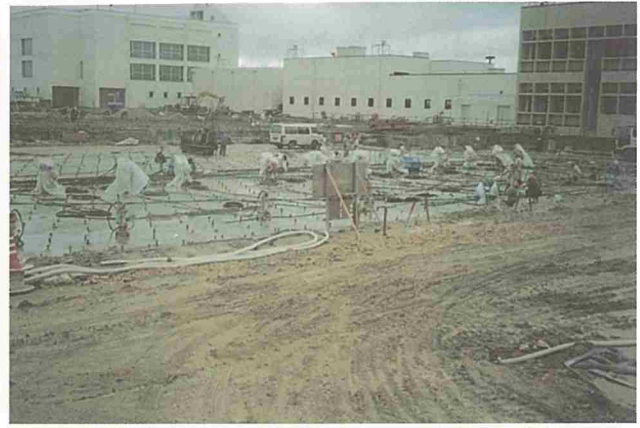
薬注工：ソレタンシュ工法（２）
