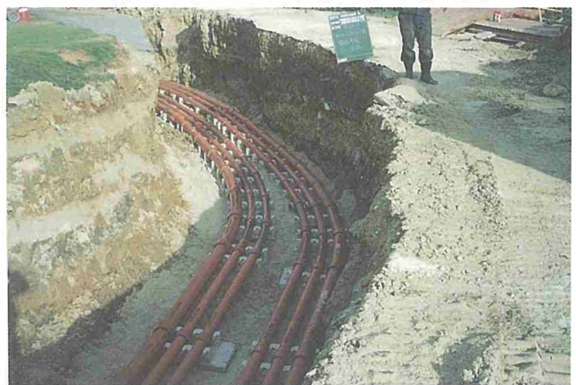
66kV 特高ケーブル用管路 (PFP管) 据付状況
