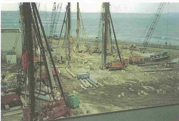
基礎及び止水工仕上（１）
