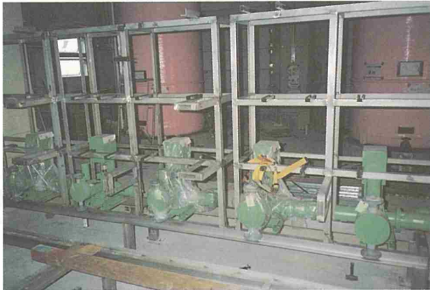
薬品注入ポンプ据付け
