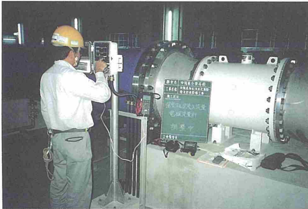
電磁流量計の試験調整
