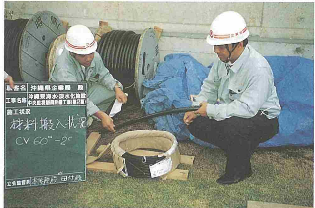
CVケーブルの搬入検査
