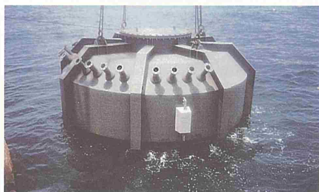
取水口の吊下し
