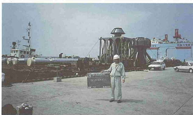
管及び取水・放流口を製作・搬入
