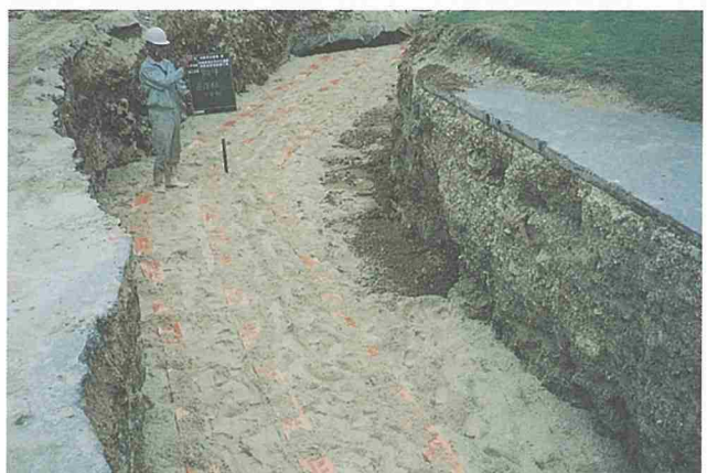
66kV 特高ケーブル用管路の埋設シート設置状況
