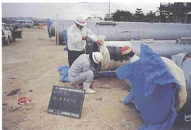
配管資材の検査 (2)
