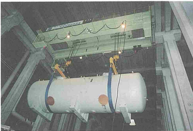
35ton 天井クレーンを用いてろ過機の設置
