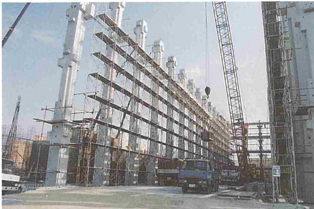
P C柱の固定 (1列)
