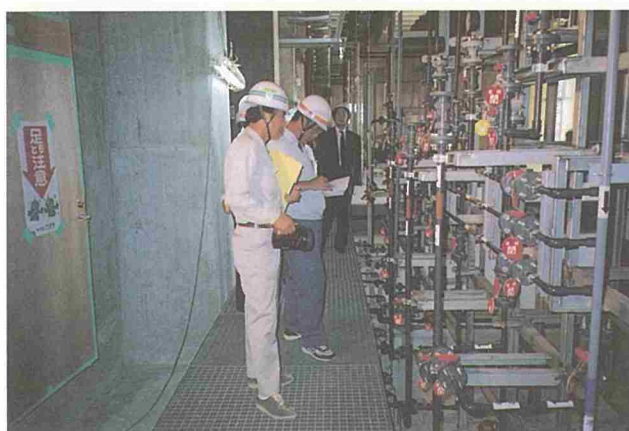
企業局検査官による竣工検査（注入ポンプ、薬品排液槽）
