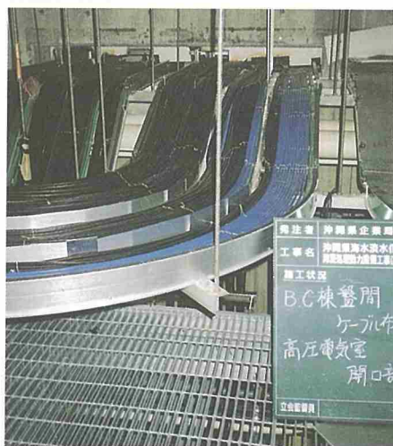
ケーブル整線状況
