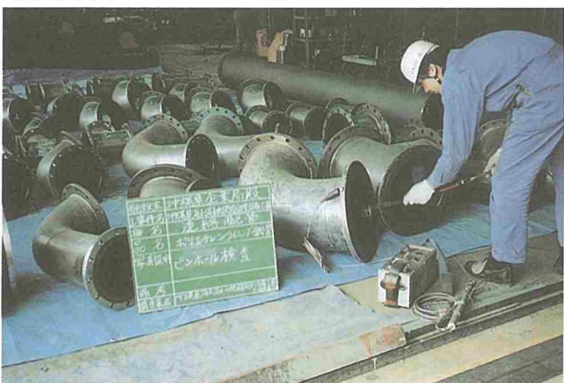
ろ過機廻りライニング鋼管のピンホール検査
