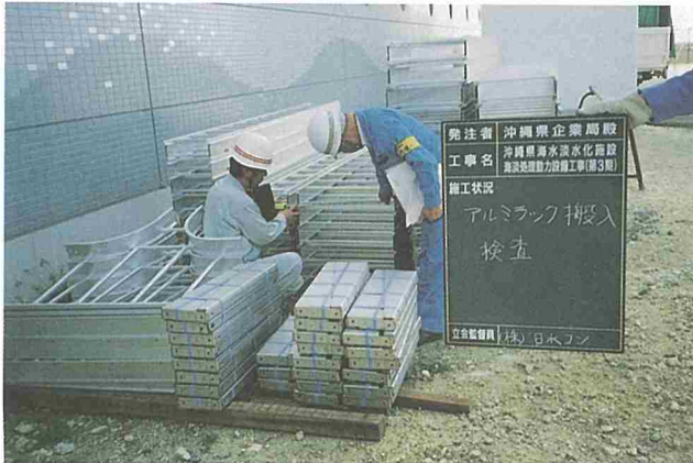
ケーブルラックの搬入検査
