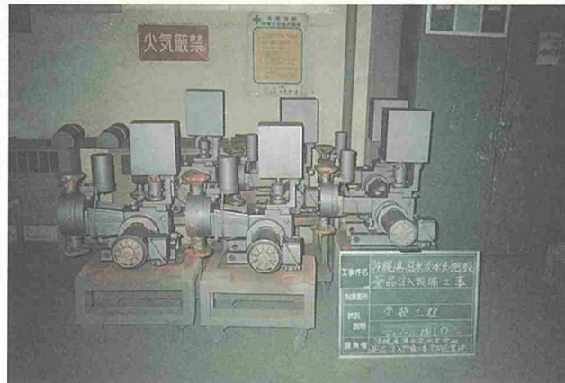
薬品注入ポンプの塗装工程
