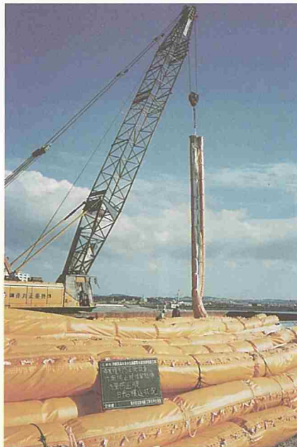
汚濁防止膜の積込み
