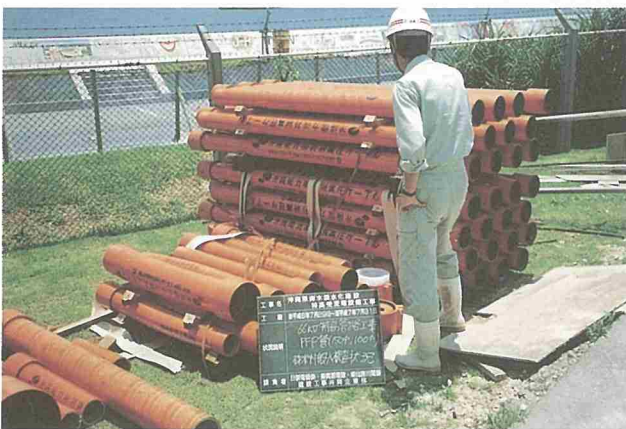
66kV 特高ケーブル用管路 (PFP管) 搬入状況
