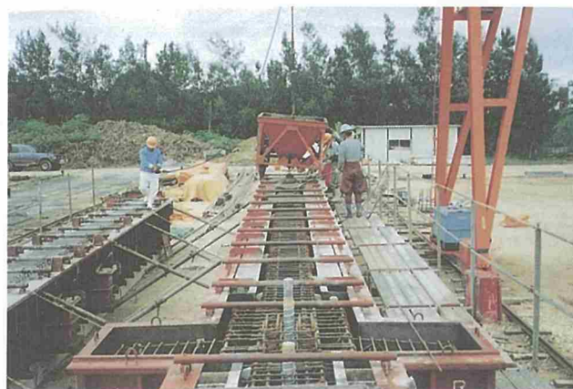
PC柱（コンクリート打設前）
