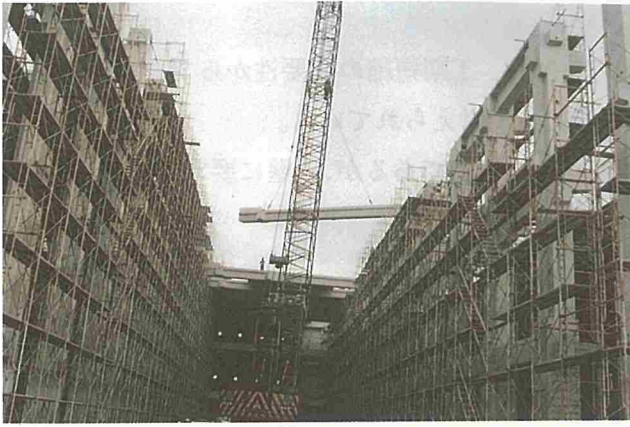
P C柱の吊込み
