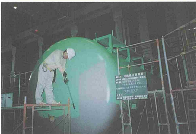
ろ過機の外面塗装
