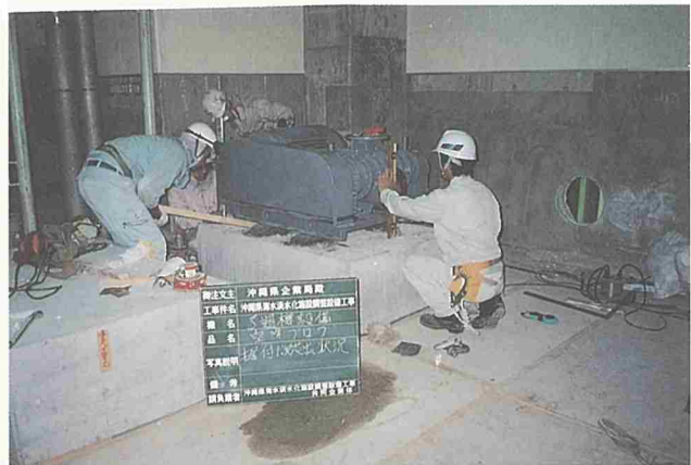
洗浄ブロワの据付
