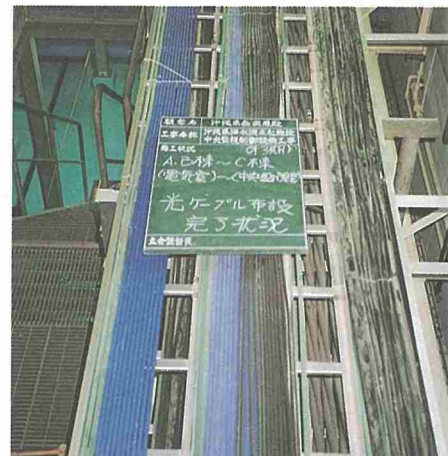
光ケーブル布設完了
