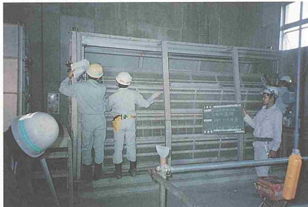
自動除塵機の設置
