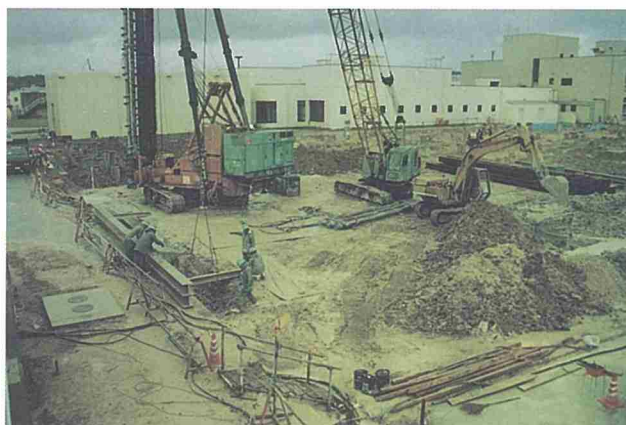
SMW工法造成（2）
