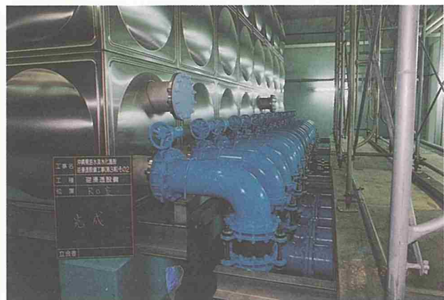
淡水水槽との接続完了
