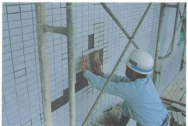
小口タイルの張付け
