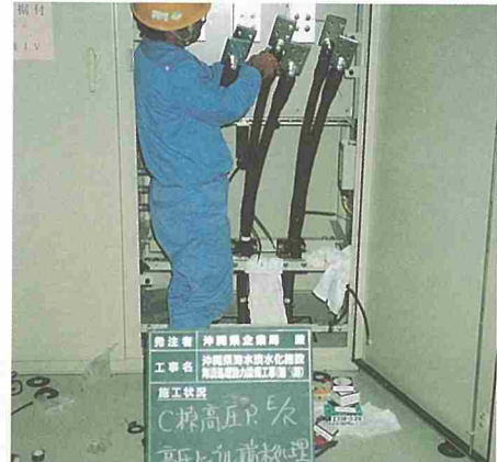
閉鎖配電への高圧ケーブル端末処理状況
