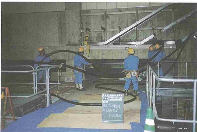
高圧ポンプへのケーブル布設状況
