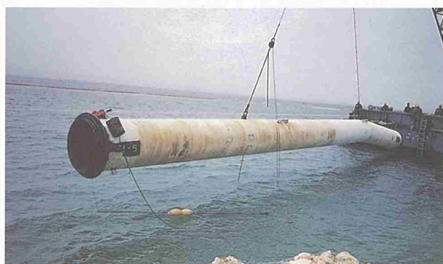
取水・放流管の吊下し作業（浅深部）
