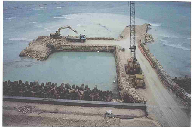
養生堤の築造 (2)
