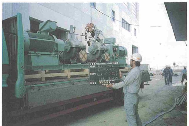
取水ポンプの搬入
