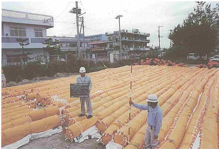
汚濁防止膜の検査
