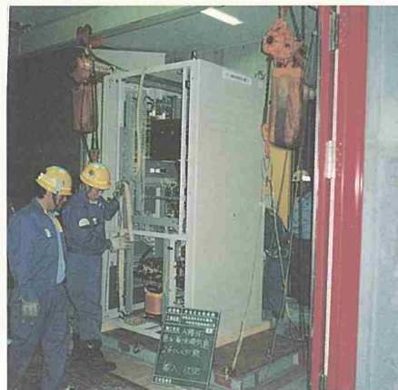
C V C F 装置の現場据付状況
