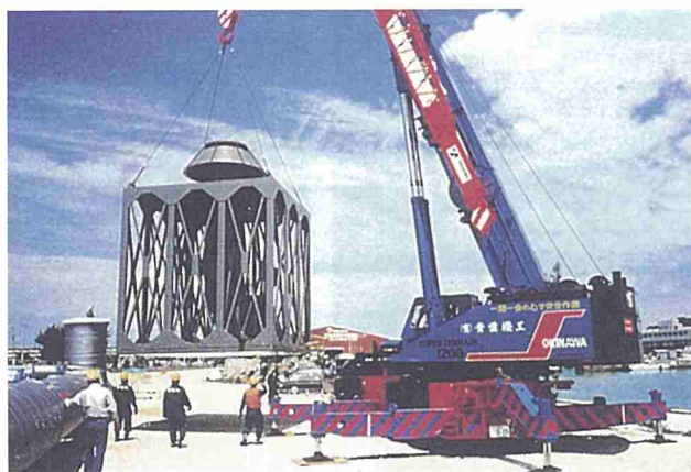
取水口の現場搬入
