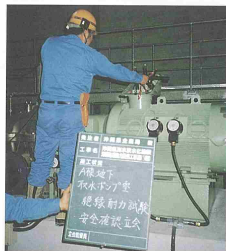
ケーブル接続後の絶縁耐力試験
