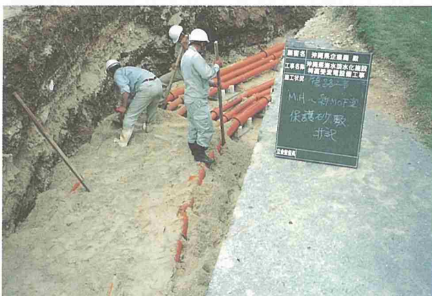
66kV特高ケーブル用管路 (PFP管) 保護砂敷状況
