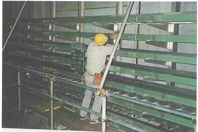
光ケーブルの布設状況
