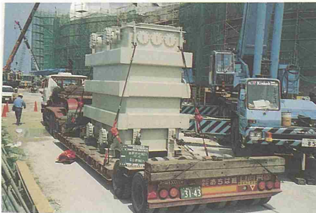
10000kVAガス絶縁変圧器の低床トレーラでの搬入
