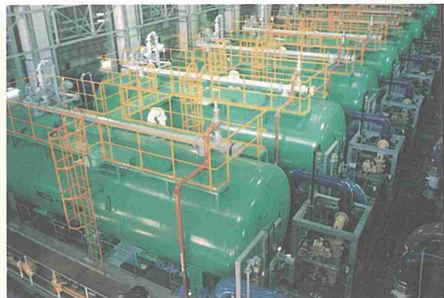
ろ過機据付完了
