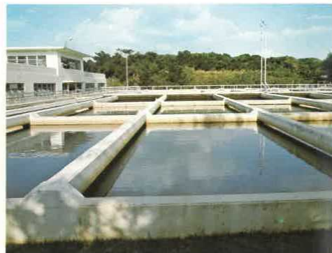
薬品沈でん池
