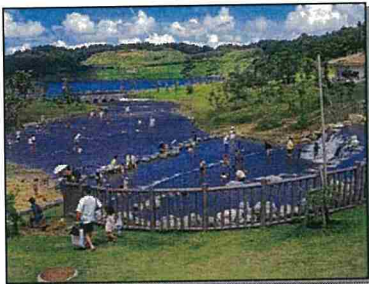
倉敷ダム (貯留施設:西系列4河川)
