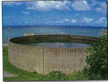
根路銘調整池 (導水施設)
