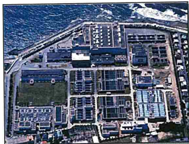
北谷浄水場 (浄水施設)
