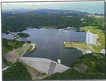
大保ダム (貯留施設:西系列8河川)
