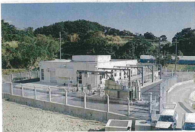
西屋部ポンプ場
