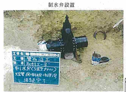
制水弁(基礎材検測)
