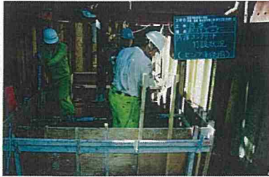
管防護工(防護コン出来形)
