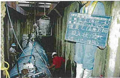
埋戻し(山原石粉)投入状況
