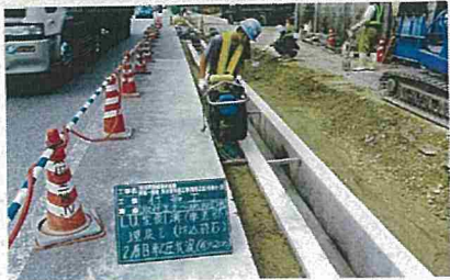
LU型側溝(埋戻し転圧)
