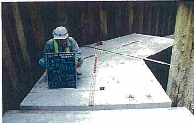
管防護工(防護コン出来形)
