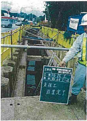
支保工設置完了
