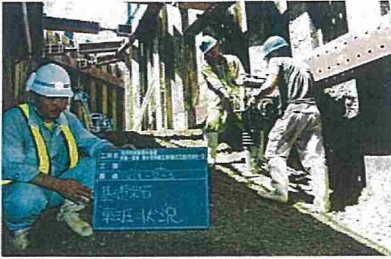
管防護工(基礎栗石転圧)
