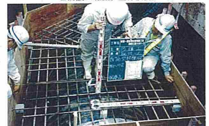
管防護工(防護コン出来形)
