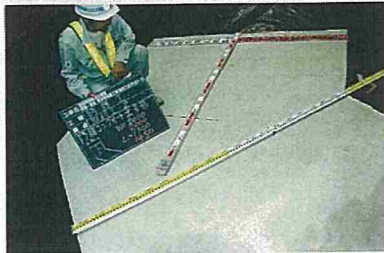
管防護工(防護コン出来形)
