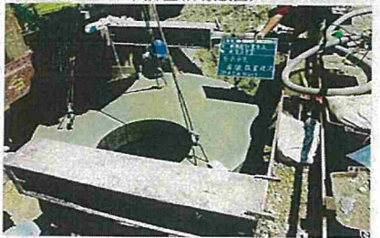
空気弁室(床版設置)
