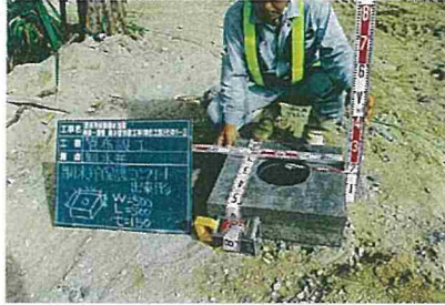
制水弁(保護コン出来形)
