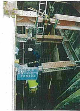
管防護工(型枠組立)
