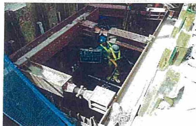
管防護工(生コン養生)
