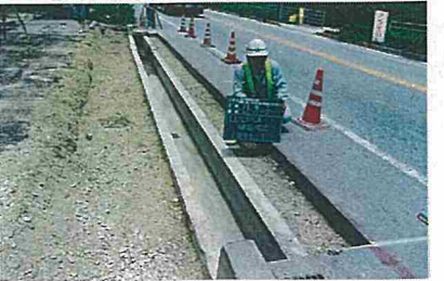
LU型側溝(破損確認)
