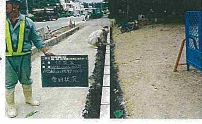
1号舗装止(製品設置)
