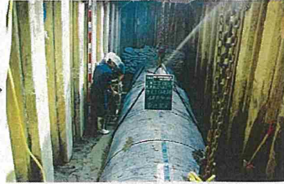
埋戻し(山原石粉)転圧状況
