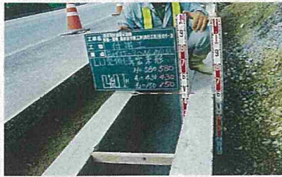
LU型側溝(製品設置)
