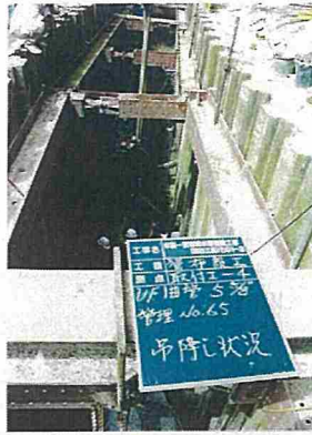
管吊降し状況
