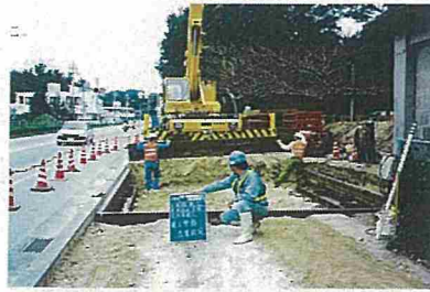
覆工板設置状況
