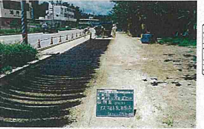
LU型側溝(破損確認)
