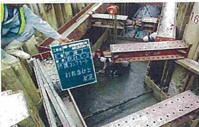
管防護工(防護コン出来形)
