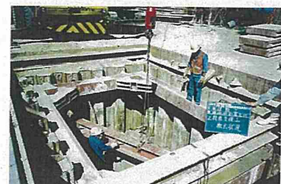
支保工設置状況
