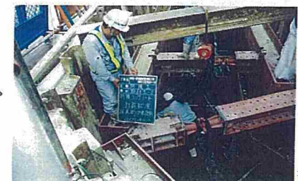
管防護工(生コン打設)
