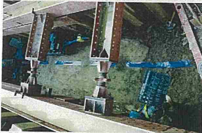
埋戻し(切込砕石)転圧状況
