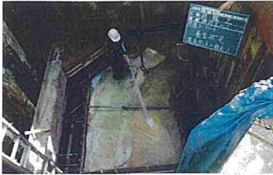
管防護工(生コン養生)
