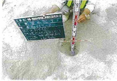
制水弁(保護コン出来形)
