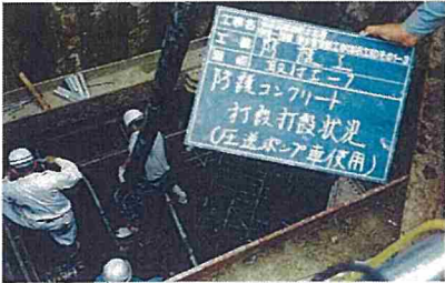
管防護工(生コン打設)
