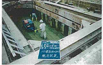
埋戻し(切込砕石)転圧状況
