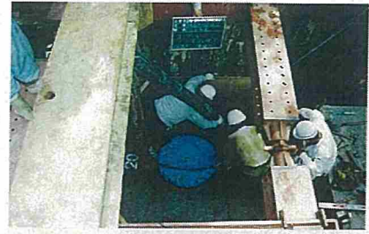
空気弁室(躯体設置)
