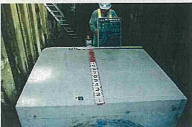
管防護工(防護コン出来形)
