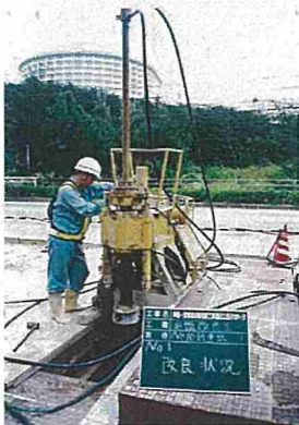
地盤改良工(改良状況)
