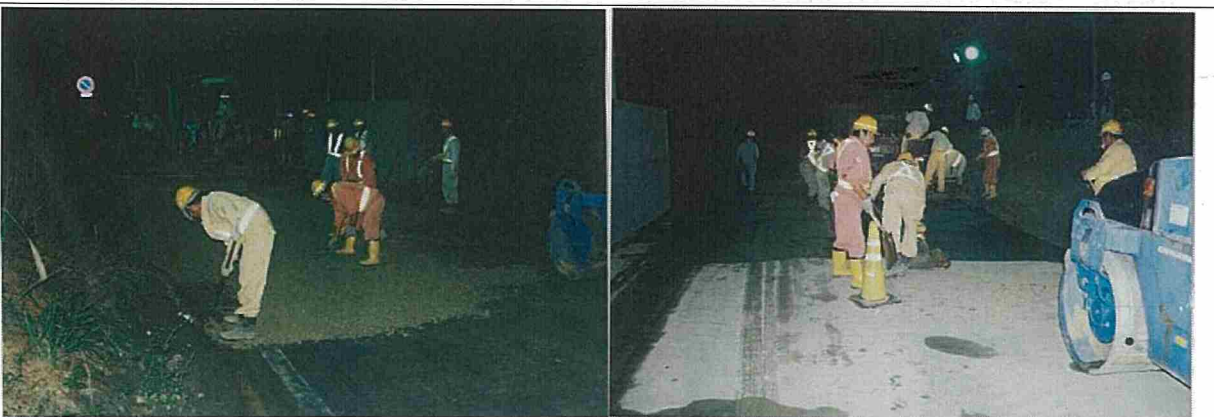
その日のうちに道路は復旧
