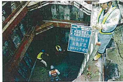
均レコンクリート打設状況
