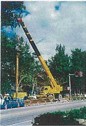
鋼矢板建込み
