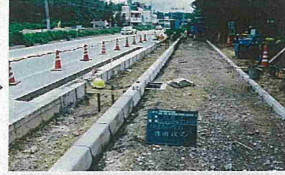
1号舗装止(製品設置)
