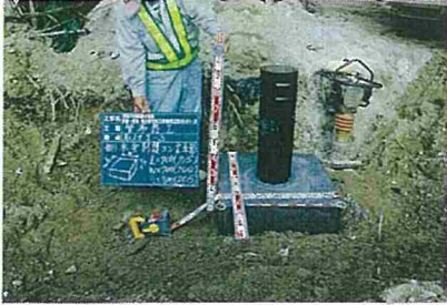
制水弁(防護コン出来形)
