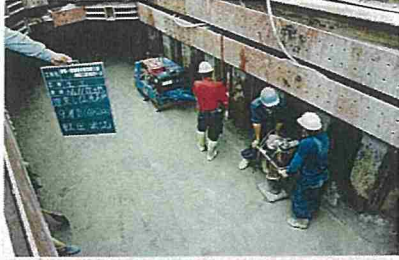
埋戻し(山原石粉)転圧状況
