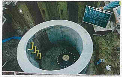
空気弁室(床版設置)
