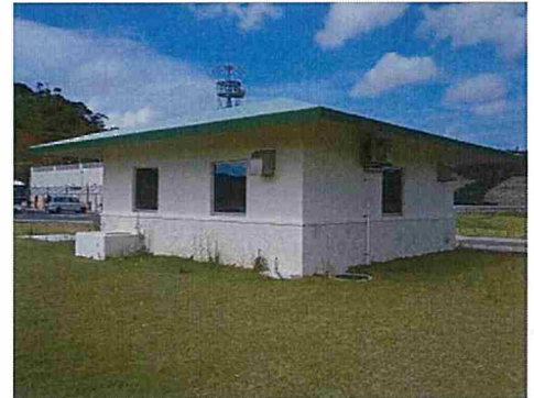
注水施設建屋 (H22. 10)
