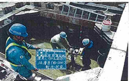
埋戻し(切込砕石)転圧状況
