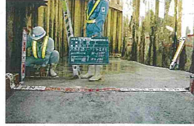
管防護工(均しコンクリート出来形)
