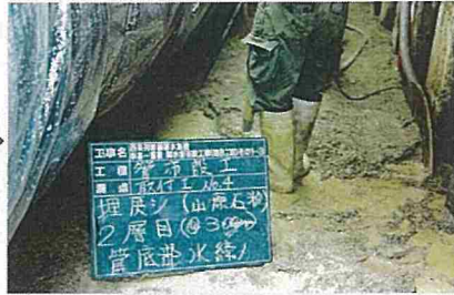
埋戻し(山原石粉)水締状況
