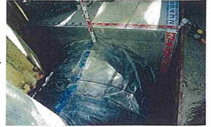
管防護工(防護コン出来形)
