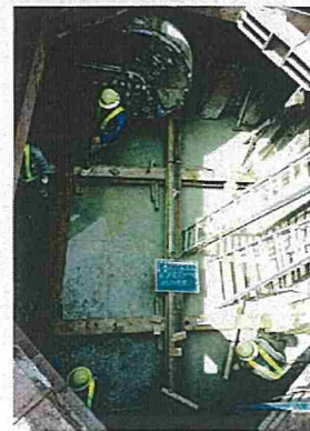
到達受台据付状況
