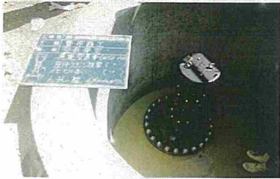
空気弁室(急速空気弁設置)
