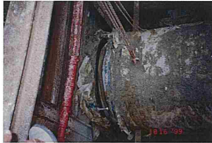
漏水箇所（平南橋左岸可撓管 E3 型）の取り外し
