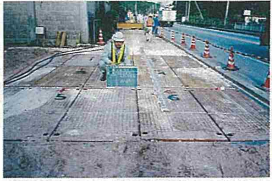
地盤改良工(孔ピッチ確認)
