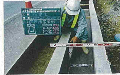
LU型側溝(製品設置)
