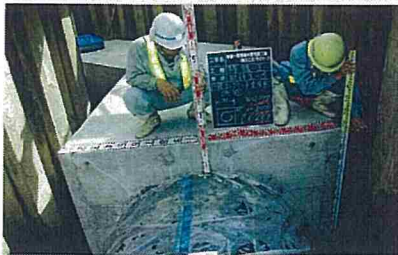
管防護工(防護コン出来形)
