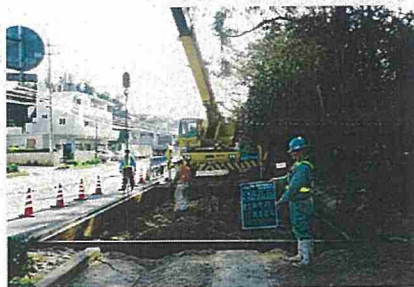
覆工板設置状況
