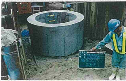
空気弁室(水圧計設置)
