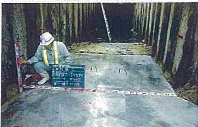
管防護工(防護コン面仕上)
