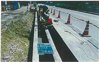
LU型側溝(埋戻し転圧)
