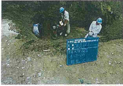
制水弁(埋設標示テープ敷設)
