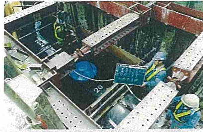
空気弁室(躯体設置)
