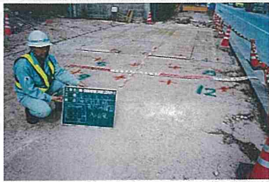
薬液注入工(孔ピッチ確認)
