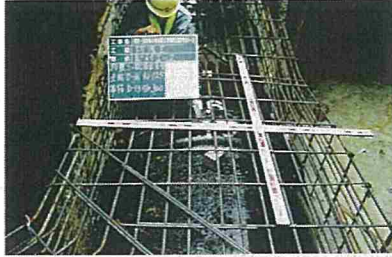
管防護工(配筋検測)
