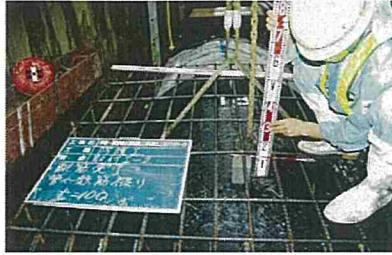
管防護工(配筋検測)
