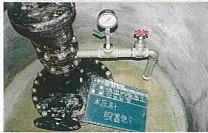
空気弁室(水圧計設置)
