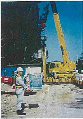
鋼矢板建込み
