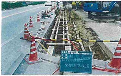
LU型側溝(生コン打設状況)
