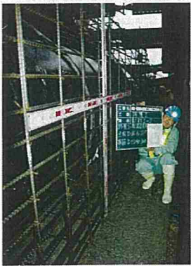
管防護工(配筋検測)
