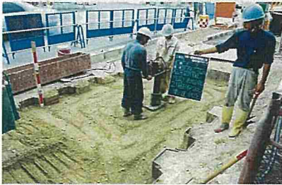
埋戻し(切込砕石)転圧状況
