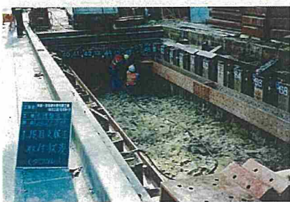
支保工設置状況
