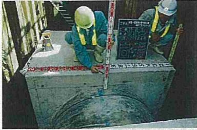
管防護工(防護コン出来形)
