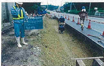
LU型側溝(基礎材転圧状況)
