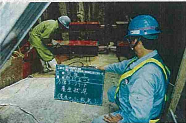
管防護工(防護コン出来形)
