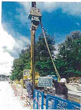
鋼矢板引抜状況
