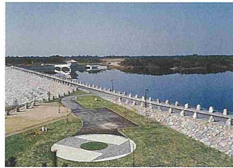
再開発後の瑞慶山ダム(倉敷ダム)
