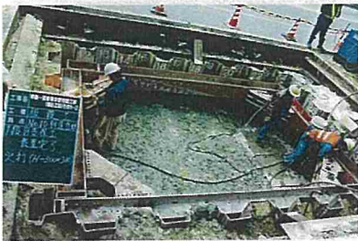
支保工設置状況
