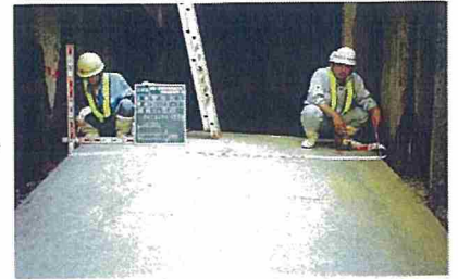
管防護工(配筋・型枠検測)
