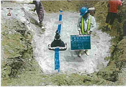
制水弁(防護コン出来形)
