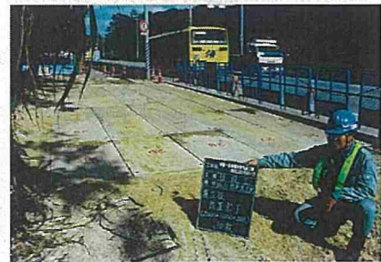
覆工板設置完了
