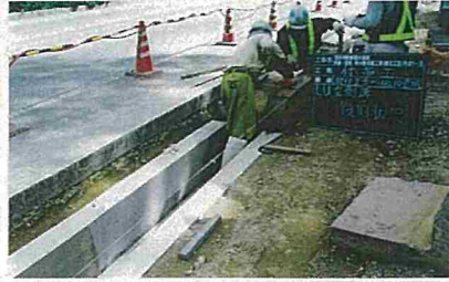
LU型側溝(製品設置)
