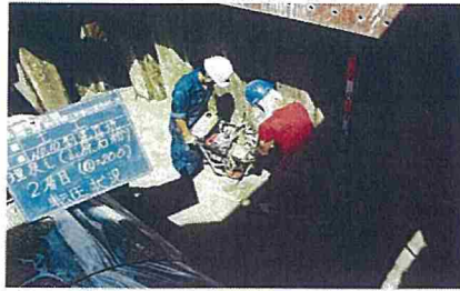
埋戻し(被り厚検測)
