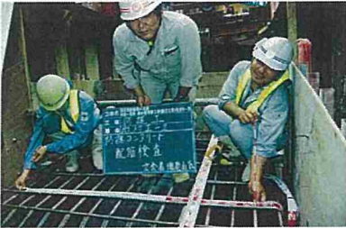
管防護工(生コン養生)
