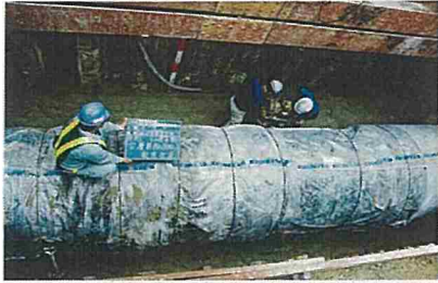
埋戻し(被り厚検測)
