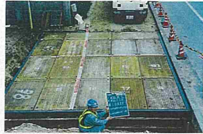
覆工板設置完了
