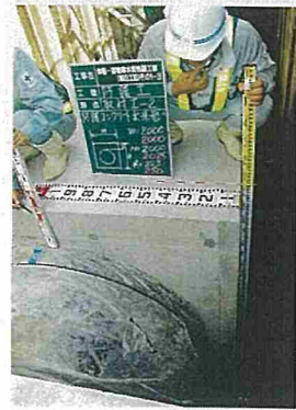
管防護工(防護コン出来形)
