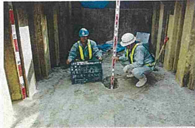
埋戻し(切込砕石)転圧状況
