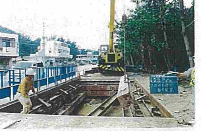
埋戻し(切込砕石)転圧状況
