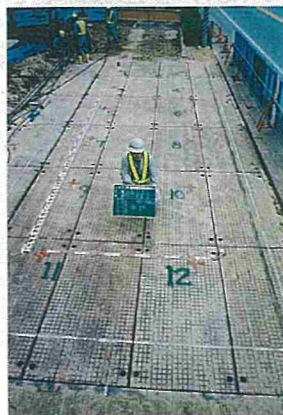
地盤改良工(孔ピッチ確認)
