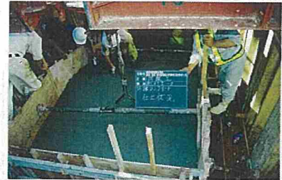
管防護工(生コン仕上)
