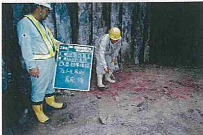
地盤改良工(改良効果確認)
