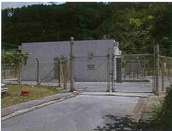
佐手前取水ポンプ場
