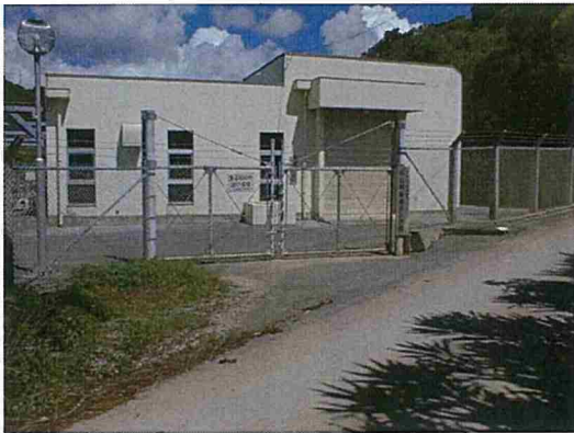
西屋部取水ポンプ場
