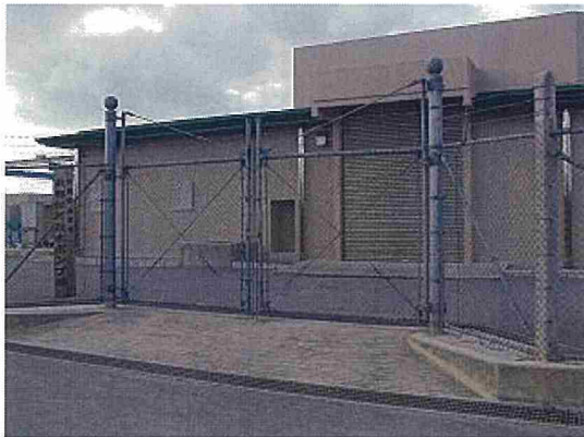
我部祖河取水ポンプ場
