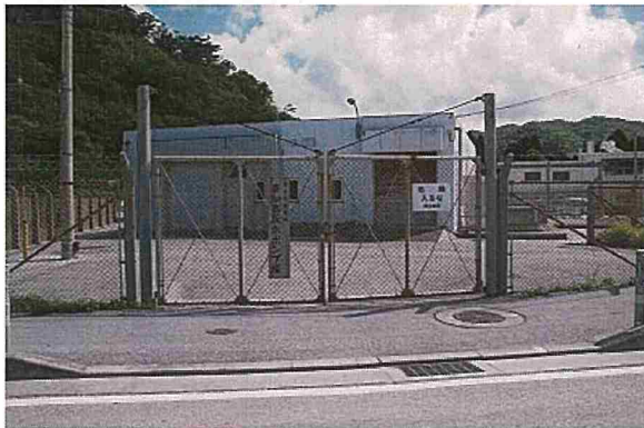
喜如嘉取水ポンプ場
