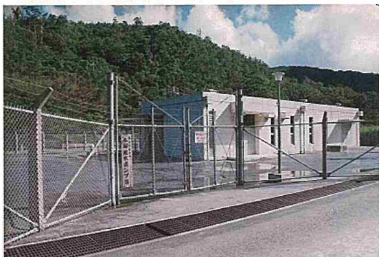
与那取水ポンプ場
