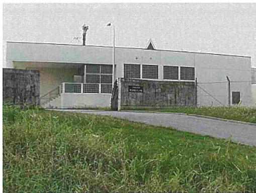
伊波増圧ポンプ場
