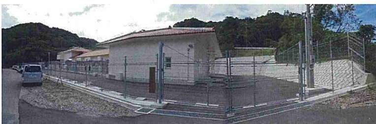
大保取水ポンプ場 全景
