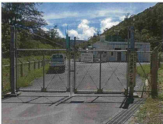
比地取水ポンプ場
