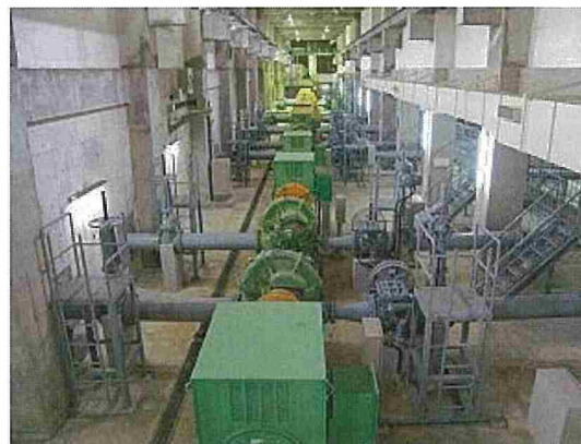
伊波増圧ポンプ場内部
