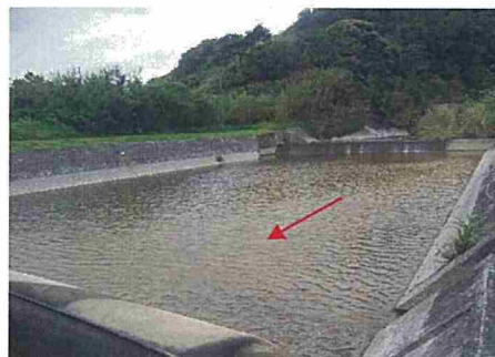
佐手川堆積土砂除去（除去後）
