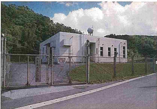
宇良取水ポンプ場
