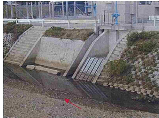
我部祖河川 取水口、魚道
