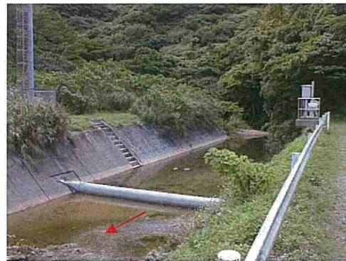
座津武川 取水堰
