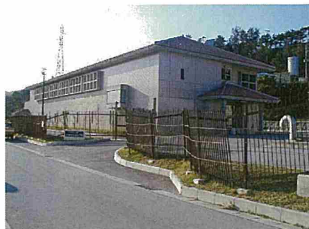
許田増圧ポンプ場
