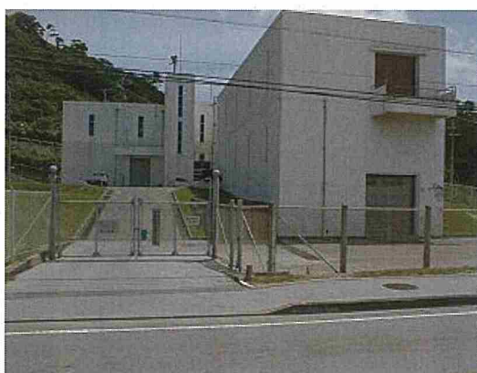
根路銘増圧ポンプ場
