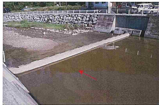
宇良川 取水堰
