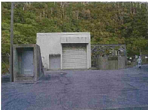
座津武取水ポンプ場
