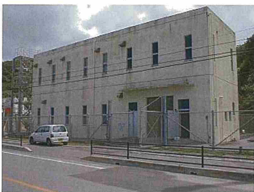
宇嘉取水ポンプ場
