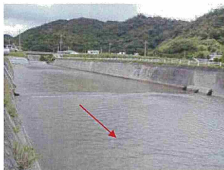
ラバー堰倒伏状態(田嘉里)
