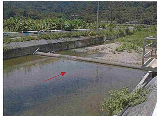
外堀田川 取水堰
