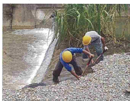
西屋部川堆積土砂（除去作業）
