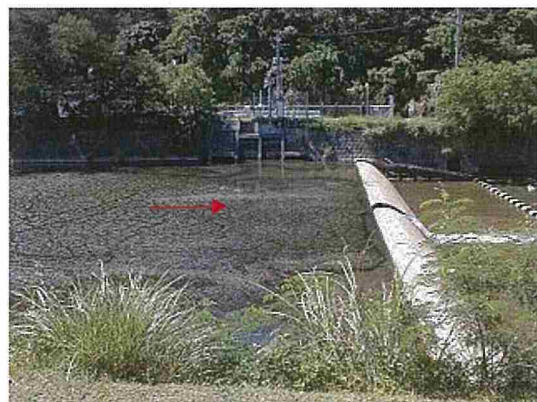
比地川 取水堰 (コンクリート堰)
