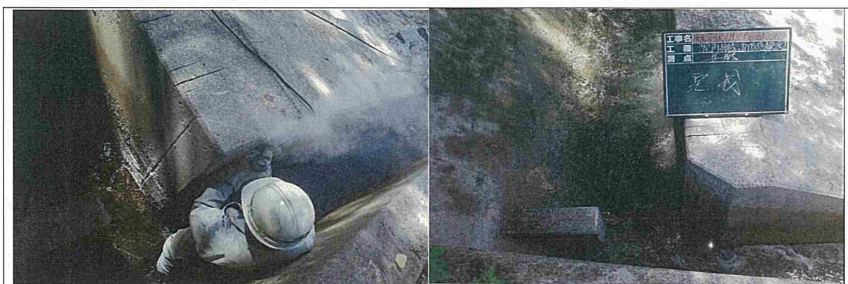
図-5.1.1 魚道屈曲部のカット作業状況（与那）
