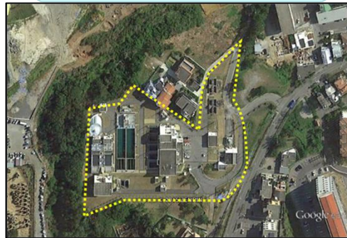
名護浄水場 浄水場の改良、耐震化、拡張、
