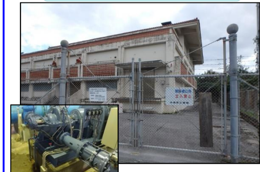
新垣増圧ポンプ場 設備の更新、耐震化
