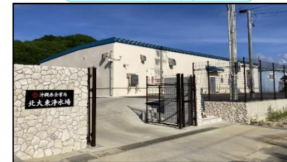
北大東浄水場 (R2.3供用開始)
