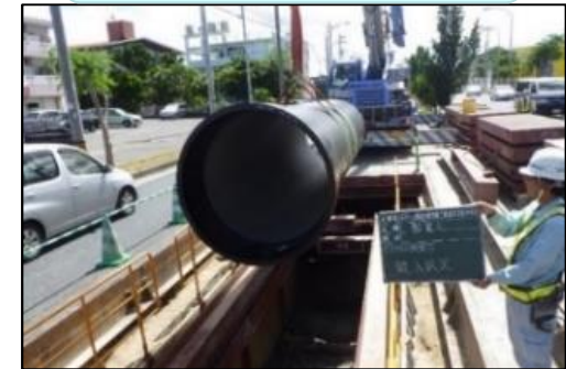
石川～上間送水管 管路の更新、耐震化
