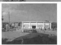
対象施設:栗国浄水場
