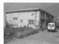
中継ポンプ場 廃止 ※バイパス管布設
