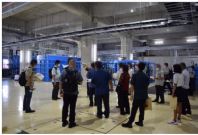
浄水場内の見学
