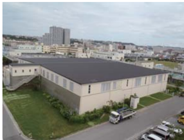
(写真) 沈でん池改良後
