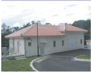
(写真)比謝川取水ポンプ場 (嘉手納町)
