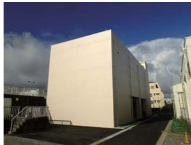
(写真) 高圧電気棟改良後
