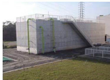
(写真) 活性炭施設の整備(新設)
