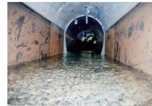
(写真) 東系列導水路トンネル内部
