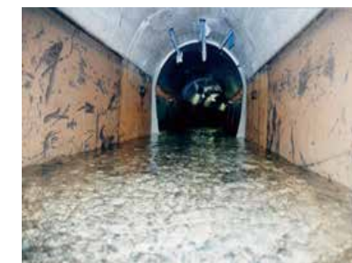
(写真) 東系列導水路トンネル内部
