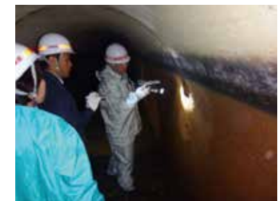
(写真) 東系列導水路トンネル内部調査状況
