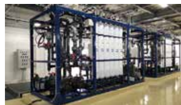
阿嘉浄水場(UF膜 前処理)
