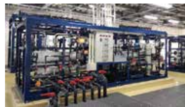
阿嘉浄水場(逆浸透膜 後処理)
