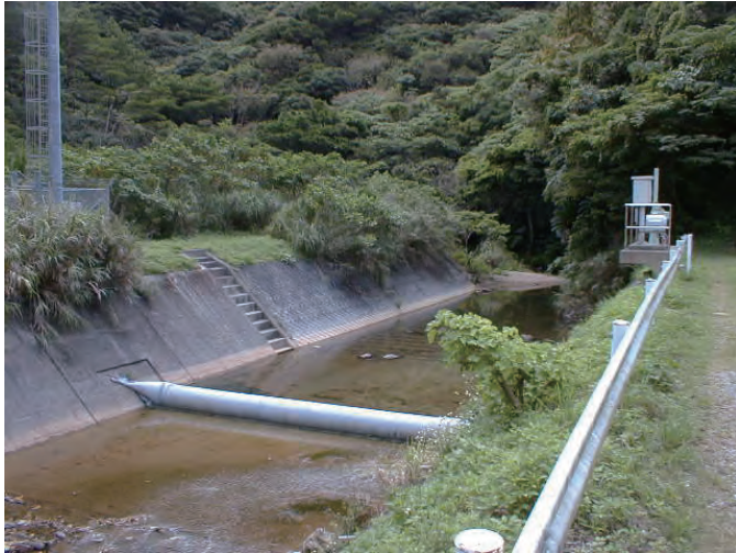
(写真)国頭村 座津武川 (座津武取水ポンプ場取水口付近)
