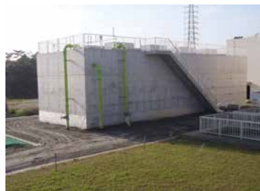
(写真)活性炭施設の整備(新設)
