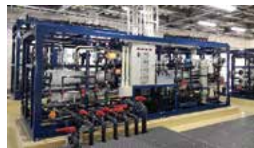
阿嘉浄水場(逆浸透膜 後処理)
