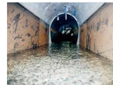
(写真)東系列導水路トンネル内部
