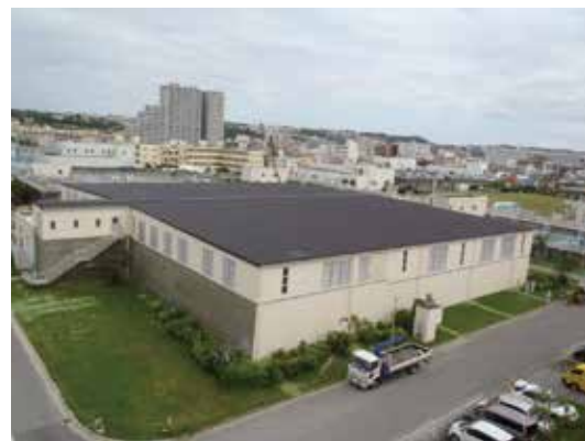
(写真)沈でん池改良後
