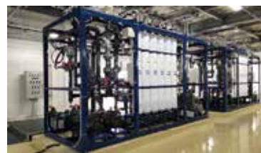
阿嘉浄水場(UF膜 前処理)
