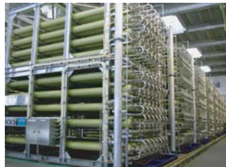
(写真) 海水淡水化センターの心臓部にあたる逆浸透設備
