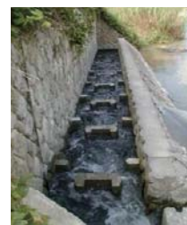
(写真) 河川魚道
