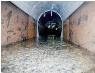
(写真) 東系列導水路トンネル内部
