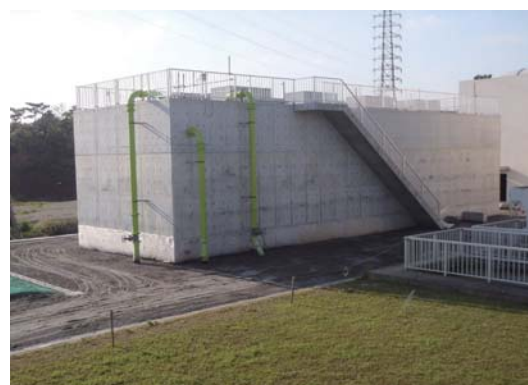
(写真)活性炭施設の整備(新設)
