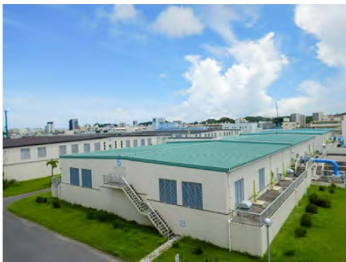
急速ろ過池改良後
