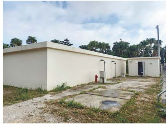
南大東調整池
