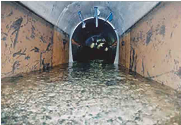
東系列導水路トンネル内部
