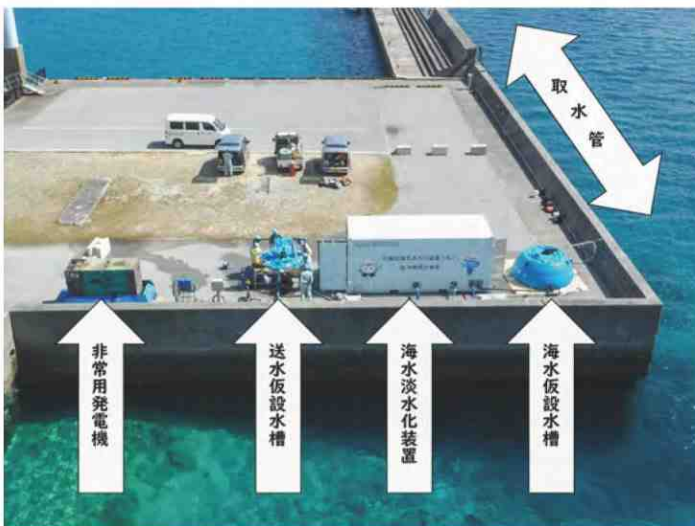
全体設置状況(阿嘉漁港内)
