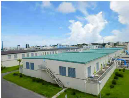
急速ろ過池改良後
