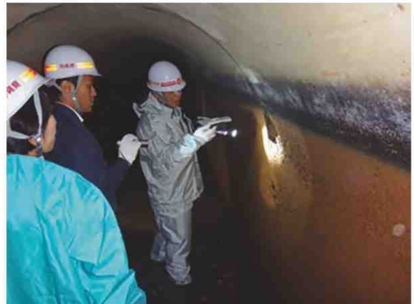
東系列導水路トンネル内部調査状況
