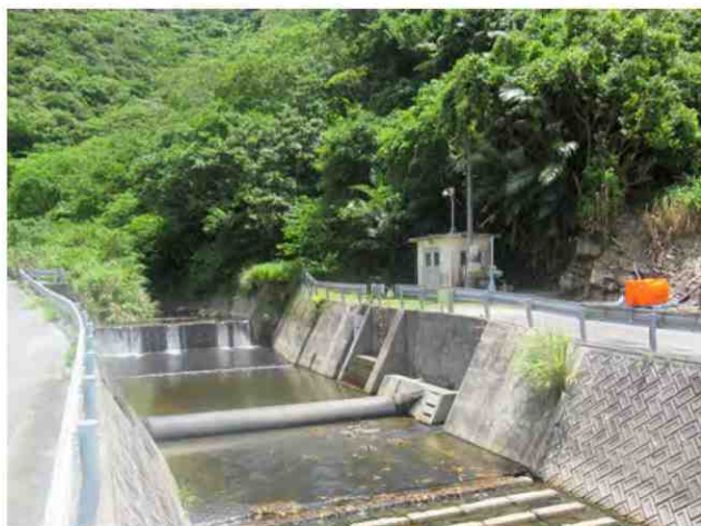
国頭村 宇嘉川 (宇嘉取水ポンプ場取水口付近)
