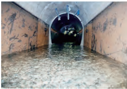
(写真) 東系列導水路トンネル内部
