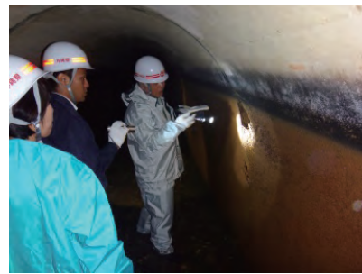
(写真) 東系列導水路トンネル内部調査状況
