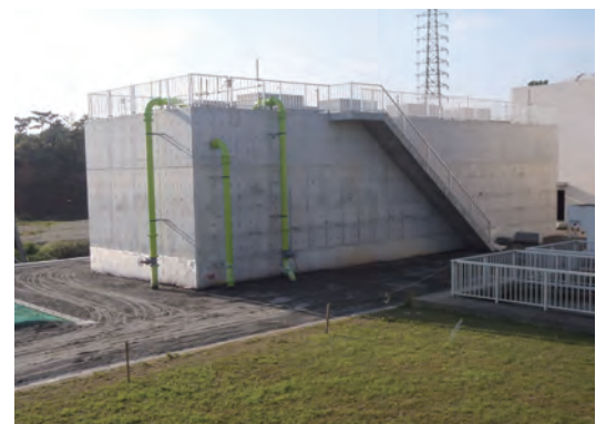
(写真)活性炭施設の整備(新設)
