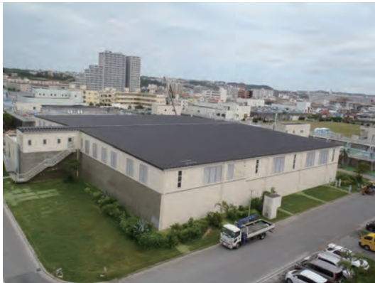
(写真)沈でん池改良後
