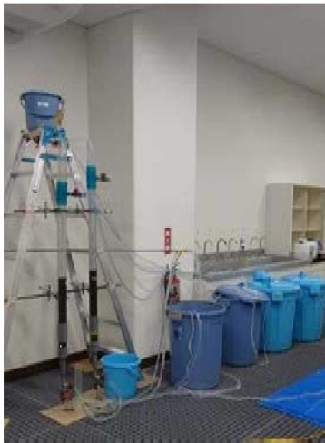
写真 4-2 マンガンろ過装置
