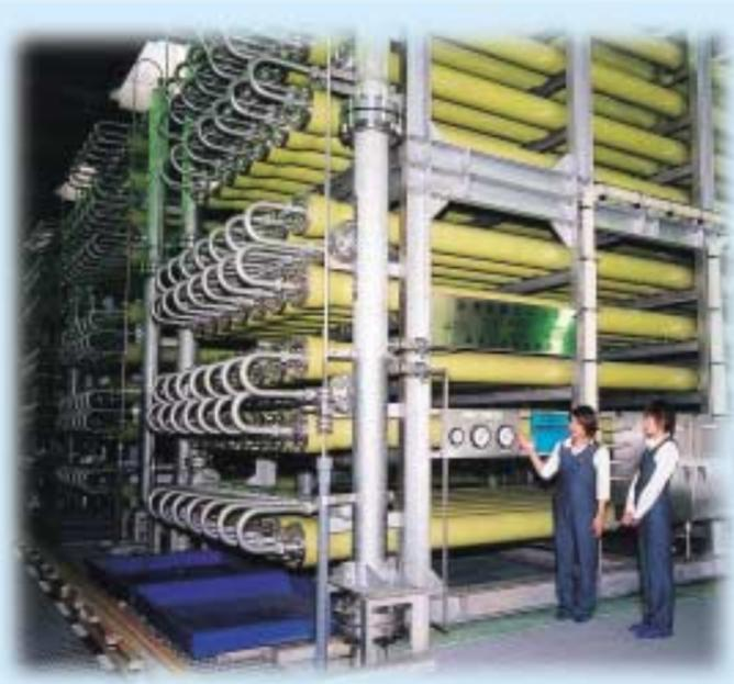
海水淡水化施設の心臓にあたる逆浸透膜設備
