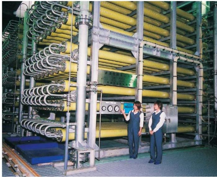
海水淡水化施設の心臓にあたる逆浸透膜設備
