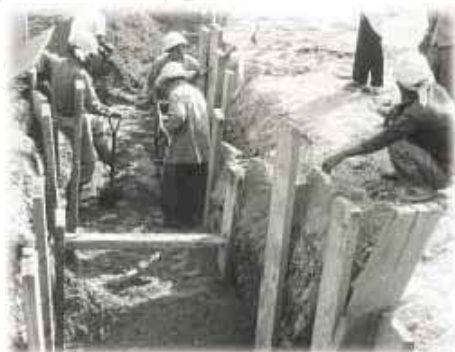
水道管布設工事の様子
