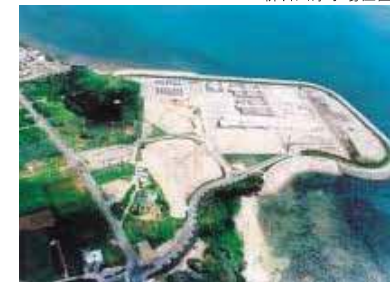
新石川浄水場建設状況(平成17年6月現在)
