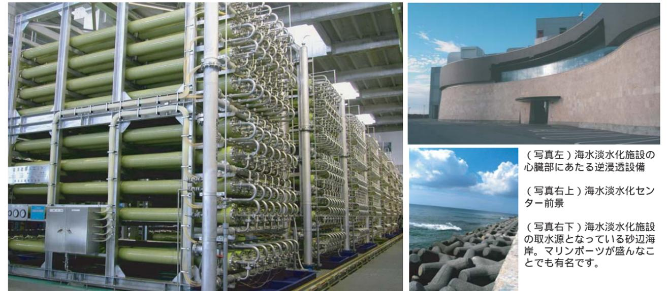
(写真左) 海水淡水化施設の心臓部にあたる逆浸透設備
