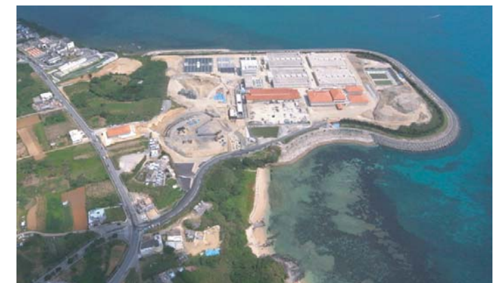
新石川浄水場建設状況(平成21年7月現在)
