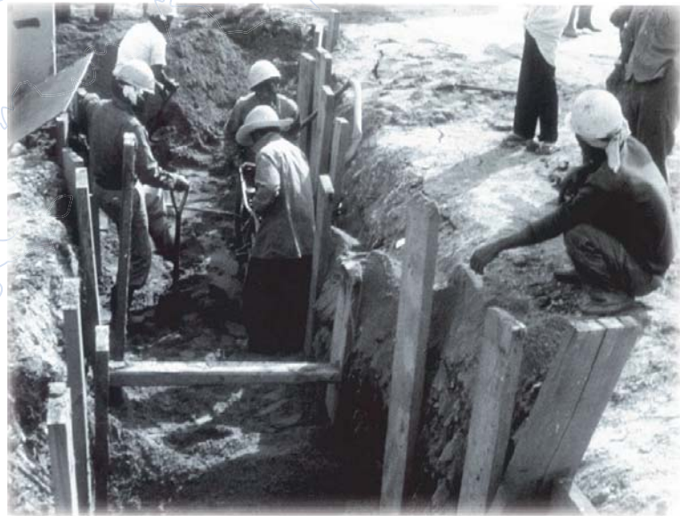
水道管布設工事の様子
