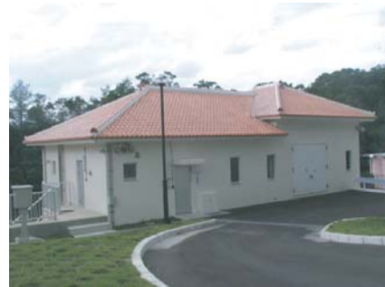
比謝川取水ポンプ場(嘉手納町)
