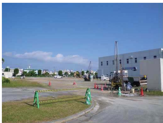
改良工事の様子
