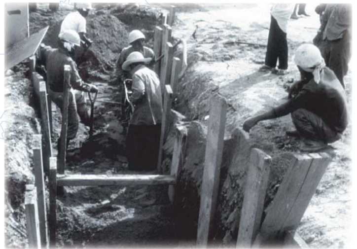
水道管布設工事の様子
