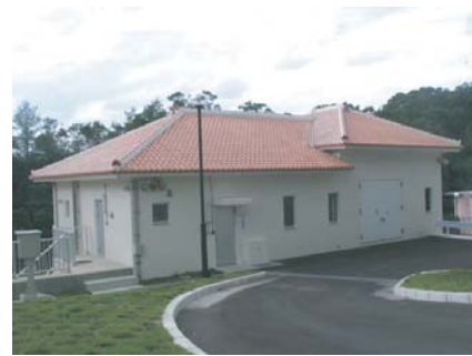
比謝川取水ポンプ場(嘉手納町)
