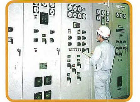
自家発電設備 台風や雷などで停電した時でも、浄水場の機械を動かせるように電気を作る機械です。
