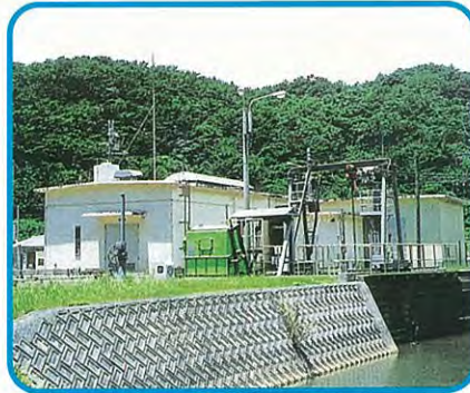
へなんしゅすい じょう 平南取水ポンプ場
