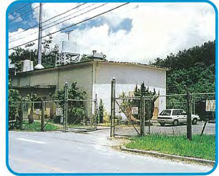
たいほしゅすい じょう 大保取水ポンプ場
