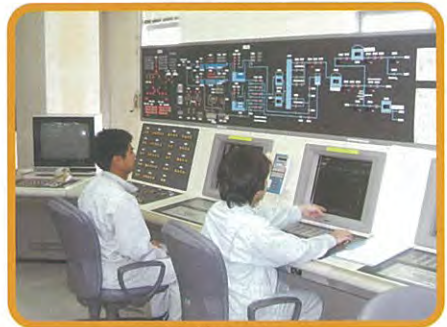
中央監視室 浄水場やポンプ場、そして調整池の水位・水量の監視・操作を行うところです。
