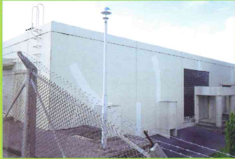
①小那覇増圧ポンプ場 能力：8,000m 3 /日
